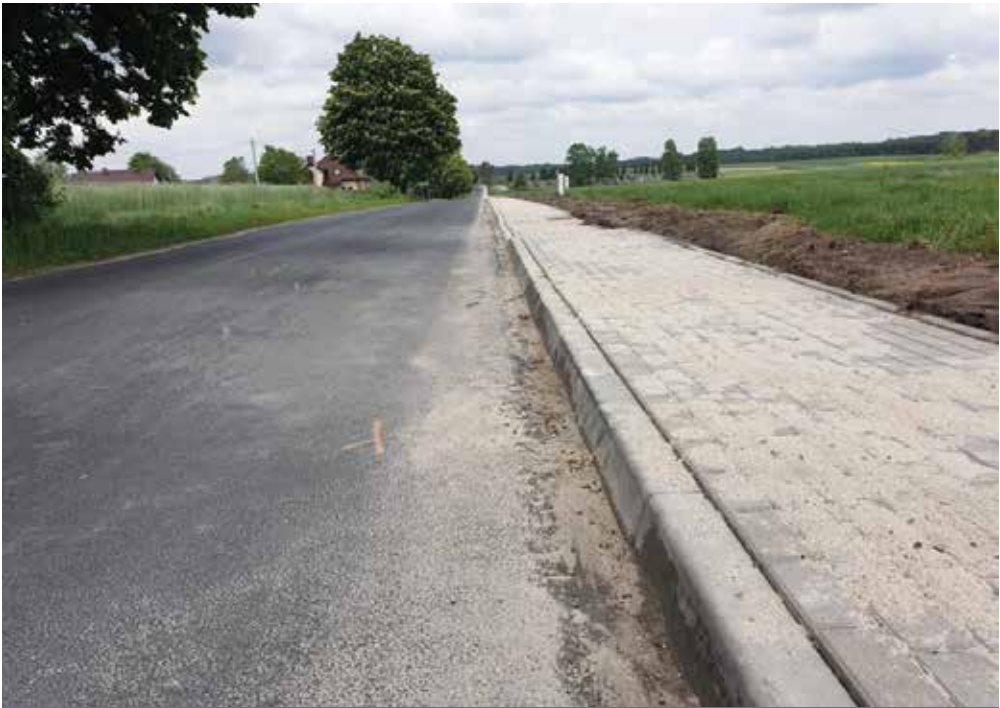
Nowo wybudowany chodnik w ciągu drogi powiatowej Nr 3647W na odcinku od m. Wodynie do cmentarza
