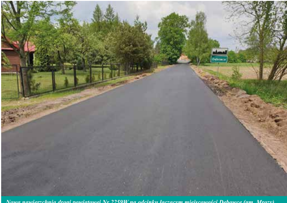
Nowa nawierzchnia drogi powiatowej Nr 2259W na odcinku łączącym miejscowości Dębowce (gm. Mrozy) i Brodki (gm. Wodynie)
