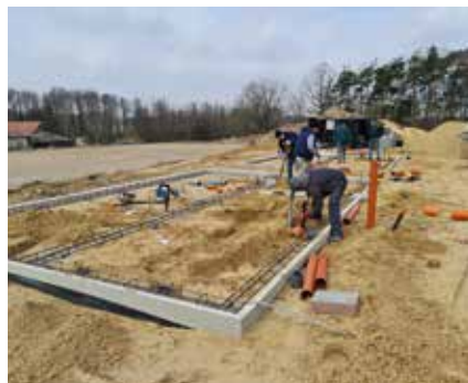
Budowa boiska sportowego typu „Orlik” w m. Ruda Wolińska
