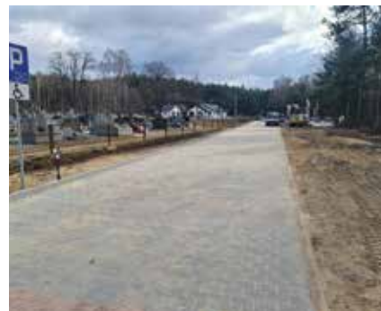
Przebudowa drogi gminnej dz. nr ew. 326 w m. Ruda Wolińska wraz z budową oświetlenia ulicznego
