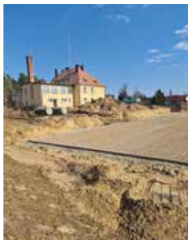
Budowa boiska sportowego typu „Orlik” w m. Ruda Wolińska
