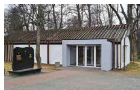
Budynek Pawilonu Turystycznego w Woli Wodyńskiej
