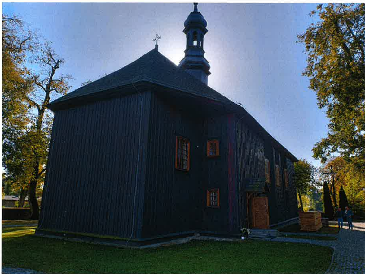
FOT. 11 Widok elewacji od strony północno-zachodniej
