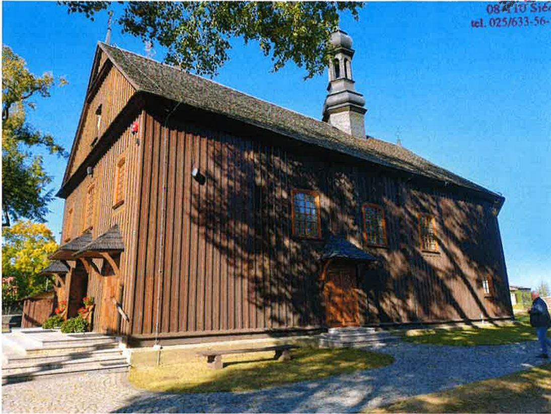
FOT. 14 Widok elewacji od strony wschodniej
