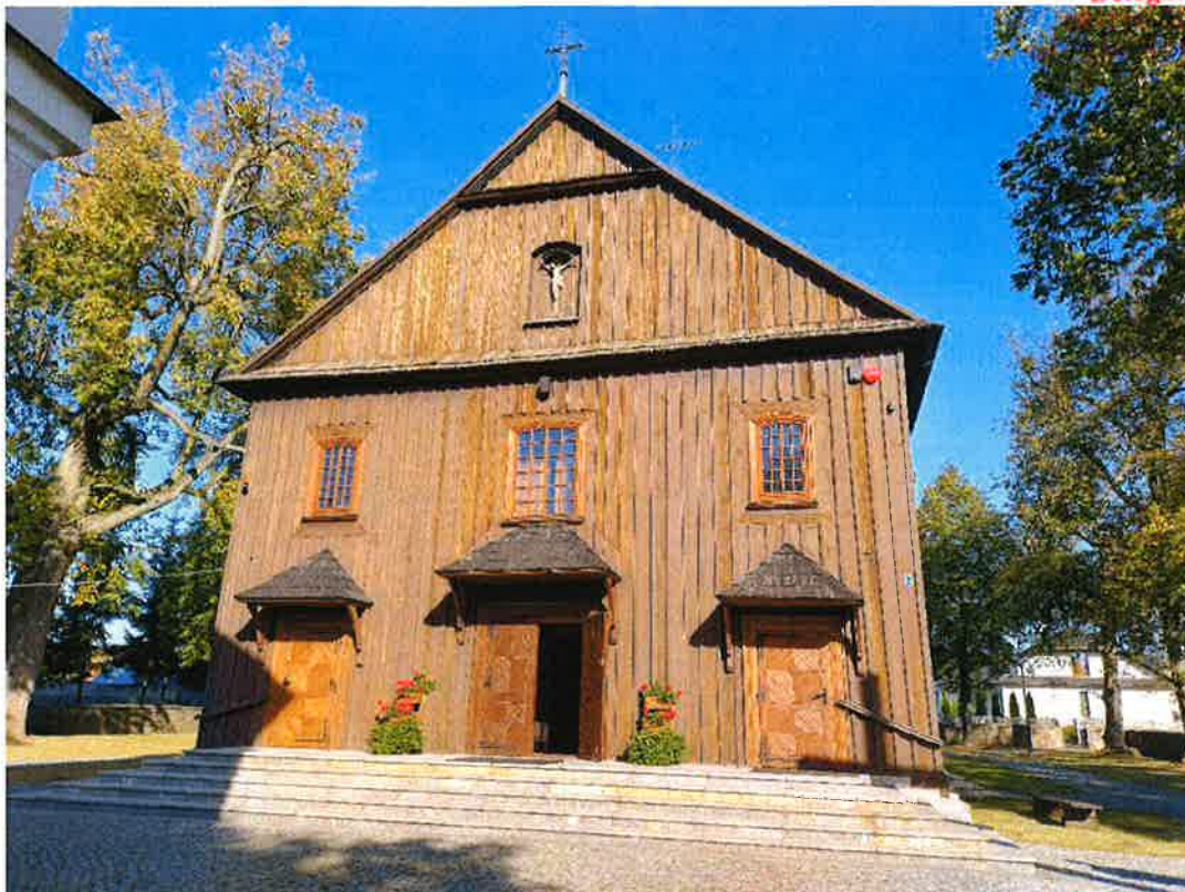
FOT. 8 Widok elewacji od strony południowej
