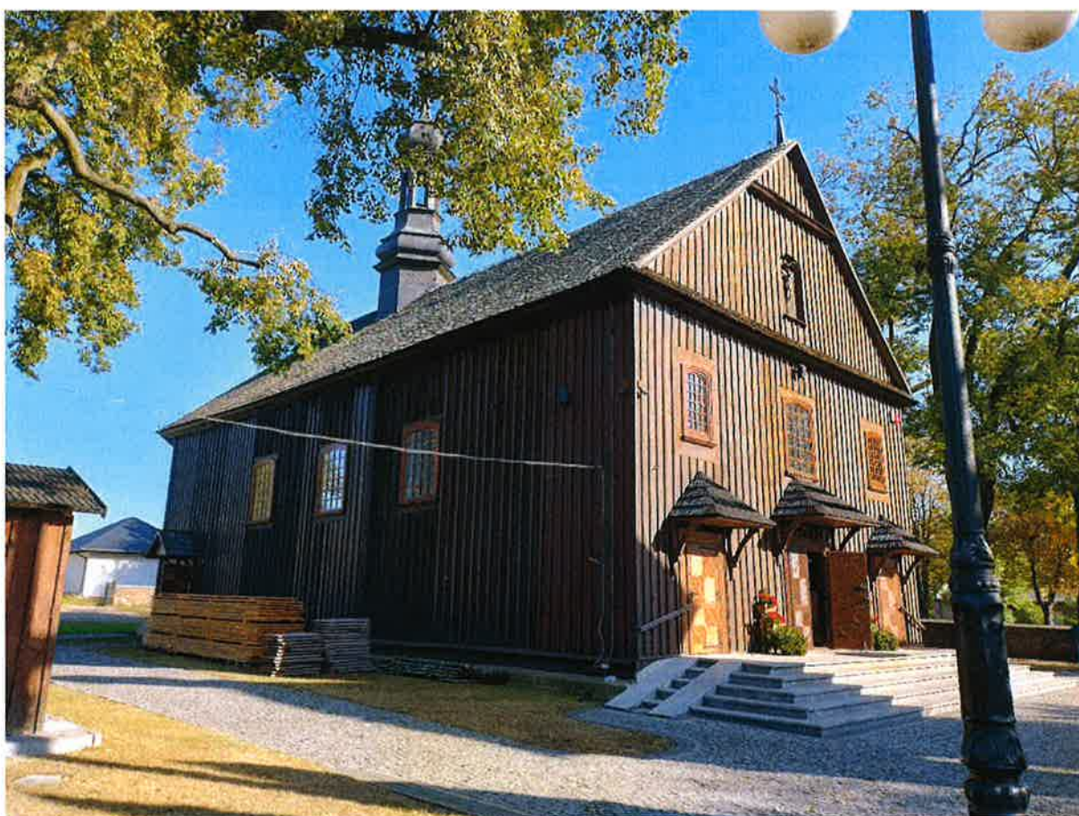
FOT. 9 Widok elewacji od strony południowo-zachodniej
