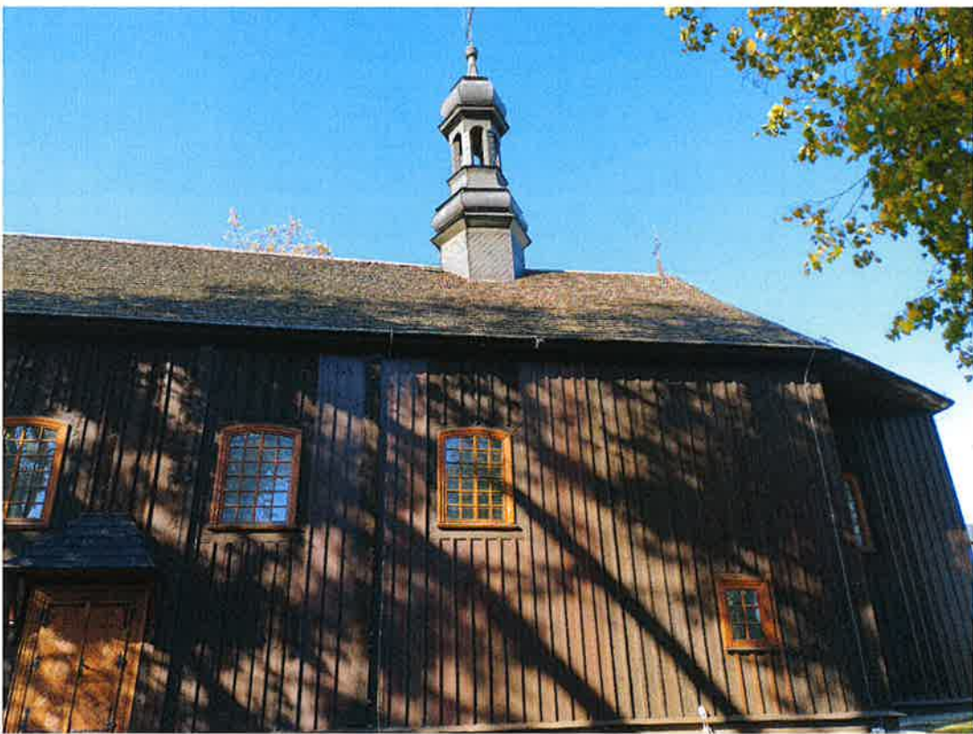
FOT. 13 Widok elewacji od strony wschodniej
