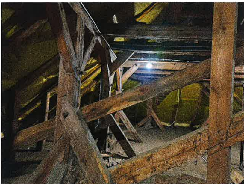
FOT. 6 Widok na konstrukcję więźby dachowej
