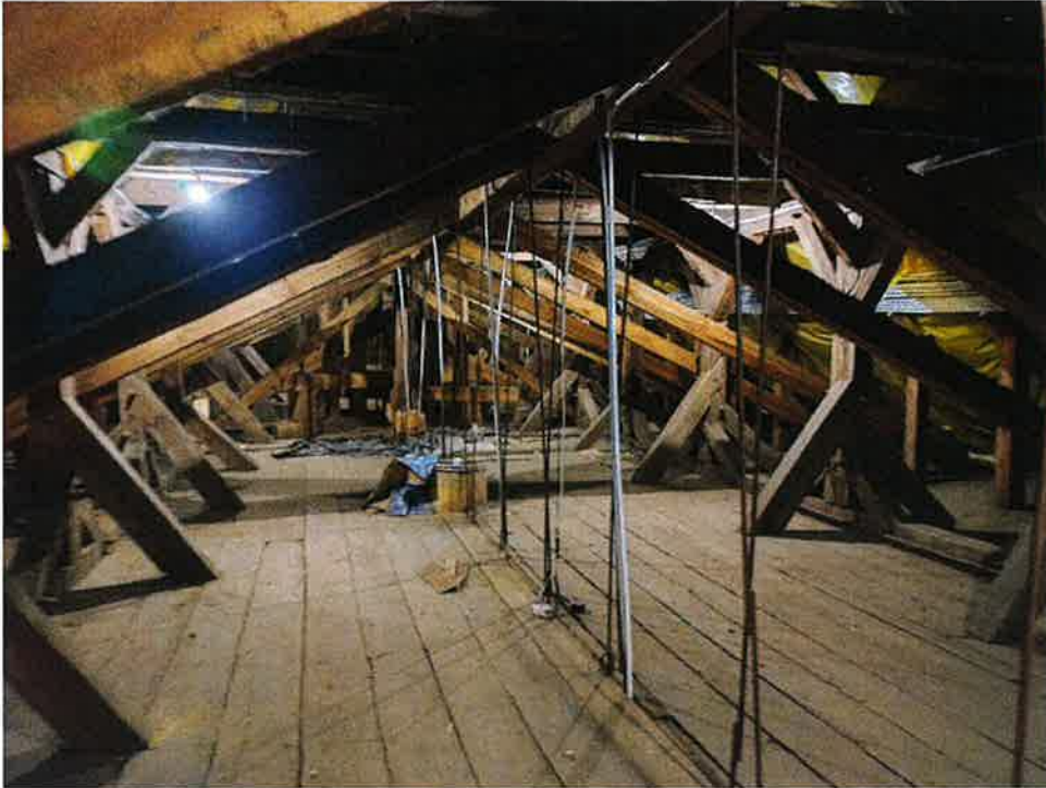
FOT. 3 Widok na konstrukcję więźby dachowej
