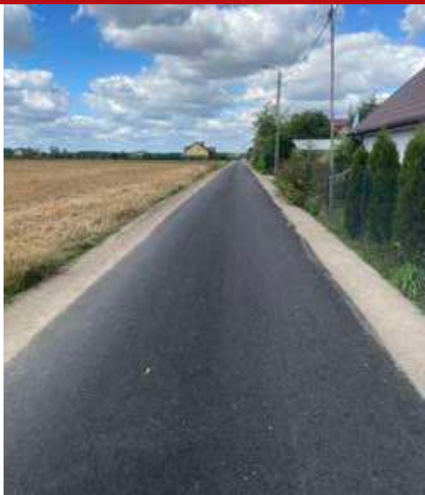
W sierpniu 2025 roku ul. Polna w Wodyniach została poddana kompleksowej modernizacji.
